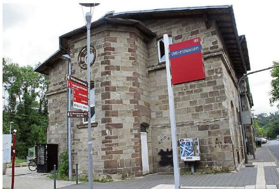
Nordbahnhof in Witzenhausen: Das Empfangsgebäude ist dicht.
